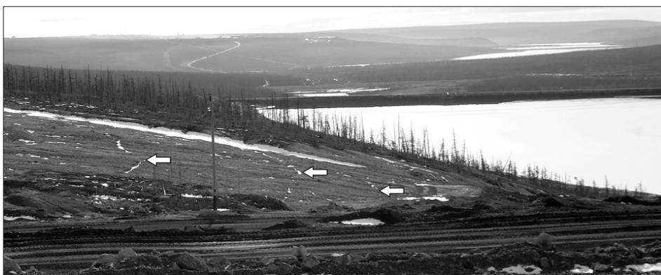
Рис. 2. Трещины отседания на левом борту низового откоса ограждающей дамбы хвостохранилища
