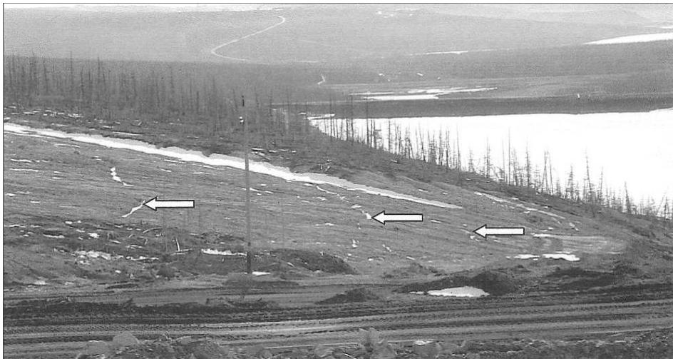
Рис. 2. Трещины отседания на левом борту в нижнем бьефе ограждающей дамбы хвостохранилища № 14
