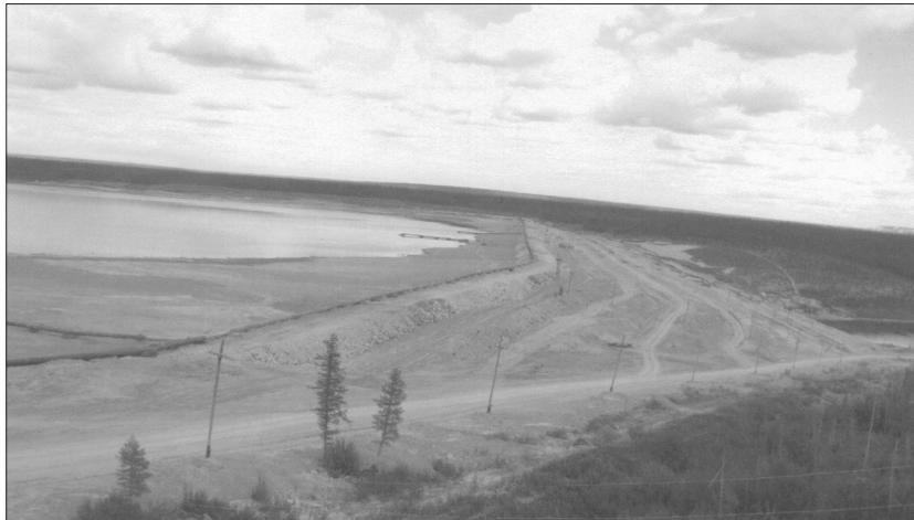
*Рис. 1. Ограждающая дамба хвостохранилища № 1*
