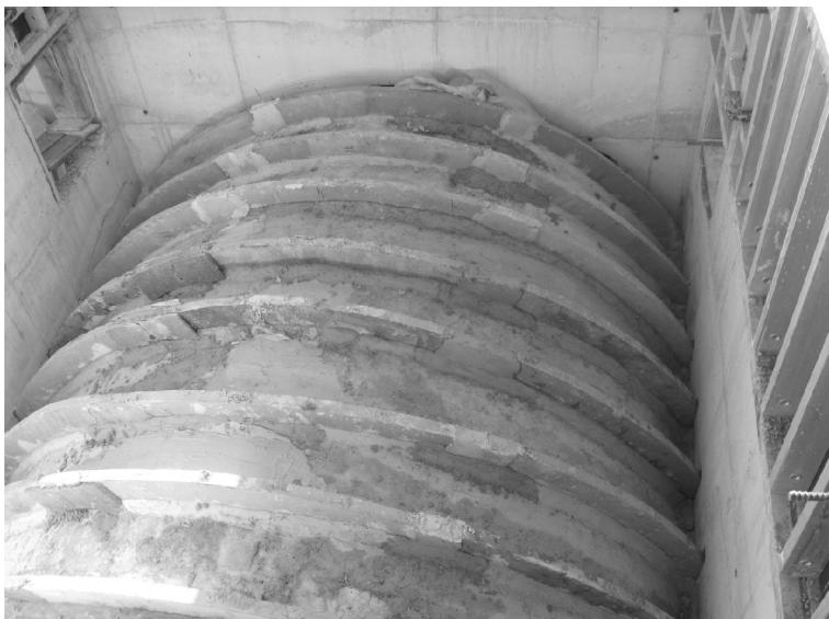
*Рис. 6. Тонкостенная ребристая стальфиброжелезобетонная оболочка покрытия*
