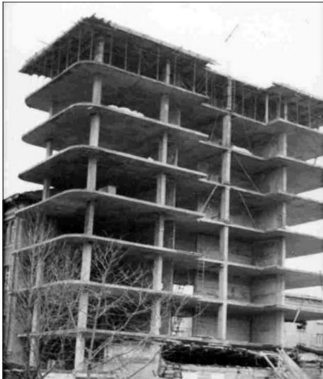
Рис. 4. Здание со сталежелезобетонным каркасом
