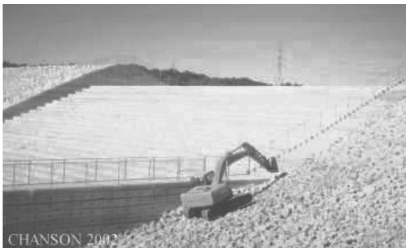
Рис. 3. Грунтовая переливная плотина с креплением низового откоса укатанным бетоном
