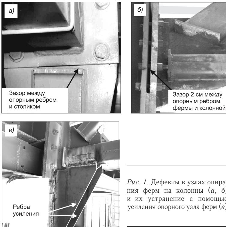
Рис. 1. Дефекты в узлах опирания ферм на колонны (а, б) и их устранение с помощью усиления опорного узла ферм (в)
