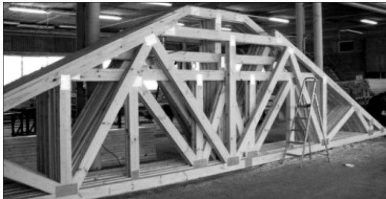
*Рис. 2. Деревянные фермы с узловыми соединениями на металлических зубчатых пластинах*
