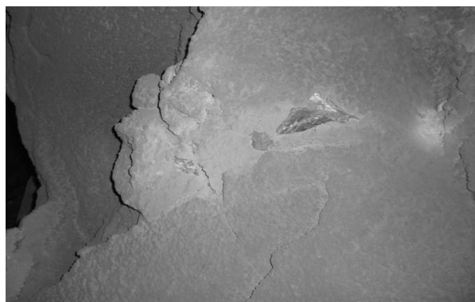
Рис. 2. Неоднородность сечения слоя торкрет-бетона, следы отскока и потеков на поверхности основания
