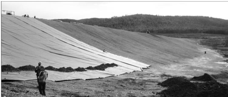
*Рис. 3. Монтаж пленочного экрана ограждающей дамбы 1-й очереди*
