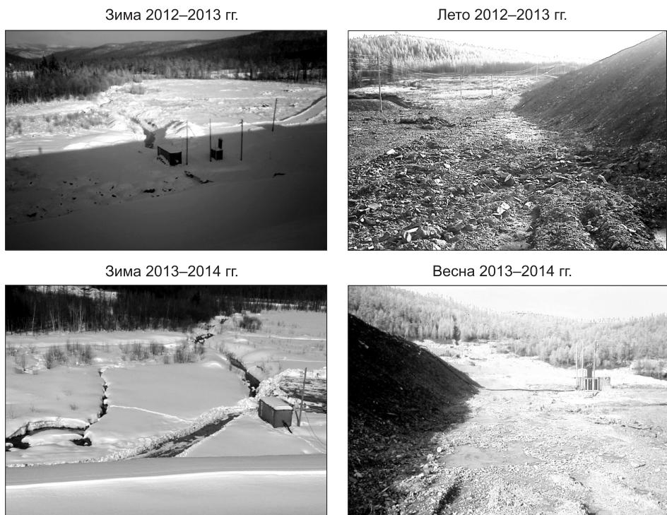
Рис. 2. Выходы фильтрационных вод у подножия ограждающей дамбы
