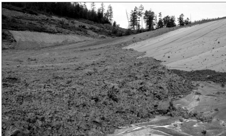
*Рис. 4. Отсыпка защитного слоя пленочного экрана ограждающей дамбы 1-й очереди*
