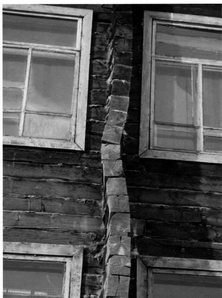
*Рис. 1. Деформации контрфорса наружной продольной стены двухэтажного здания средней школы (с. Мухор-Тархата, Республика Алтай)*
