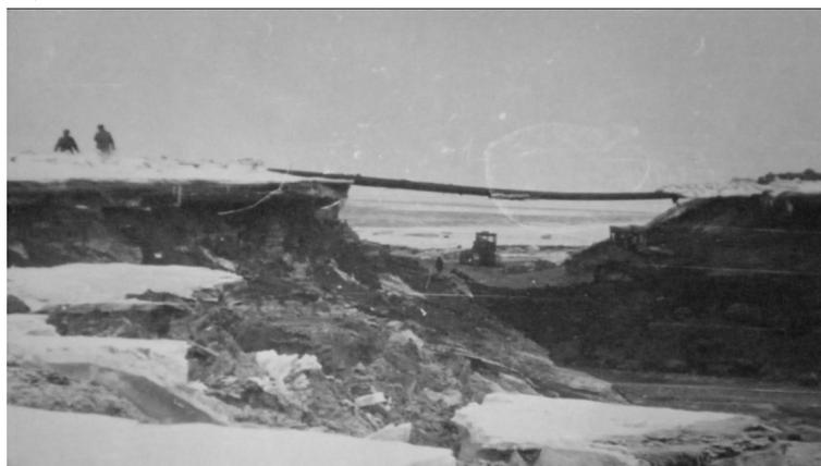
*Рис. 1.* Разрушение ограждающей дамбы золоотвала № 1 Абаканской ТЭЦ
