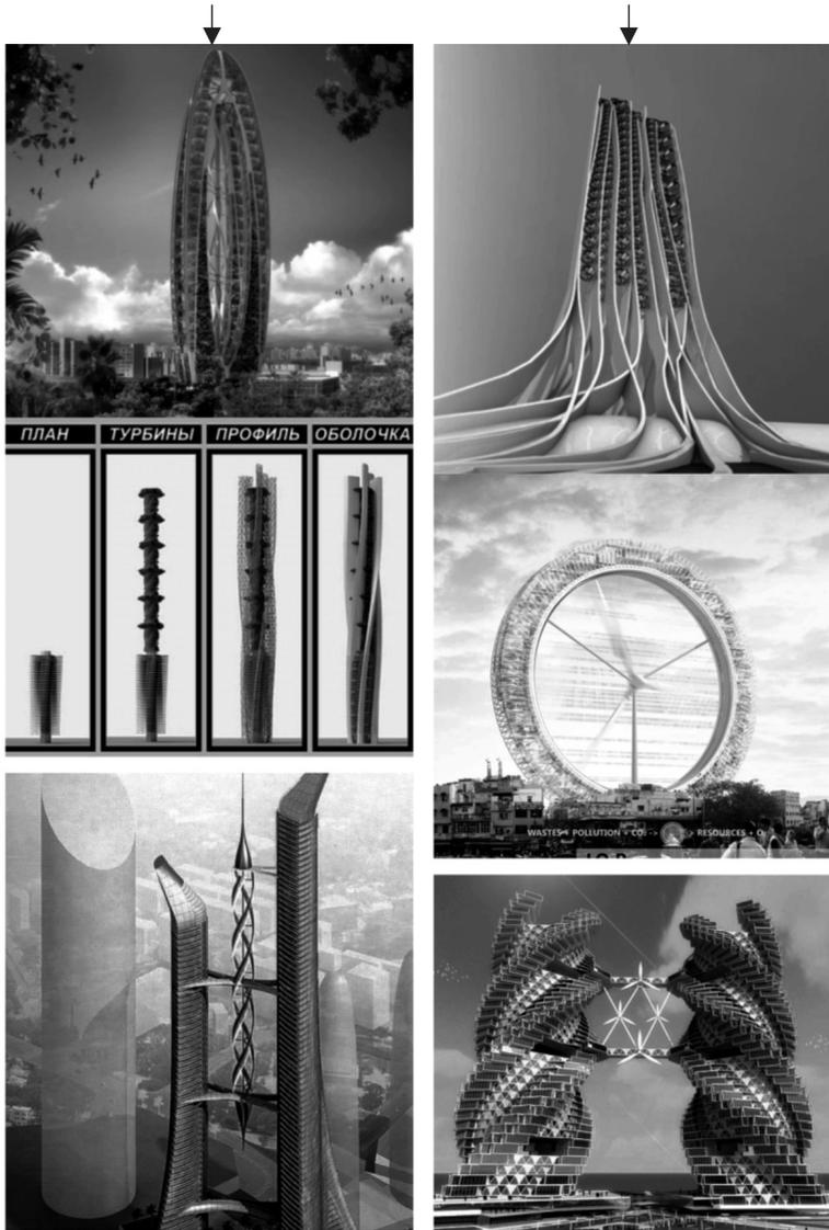
Рис. 1. Типы ветрогенераторов и примеры проектов высотных зданий, в которых они применены
