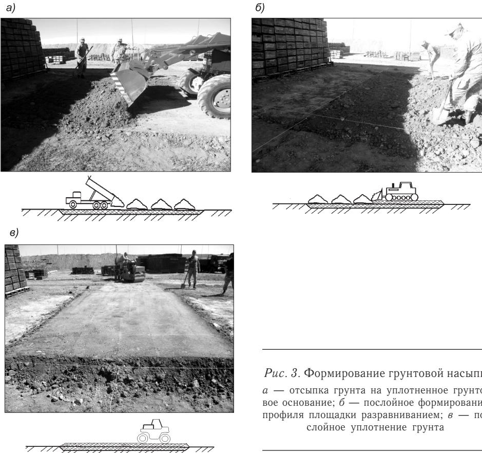
Рис. 3. Формирование грунтовой насыпи
