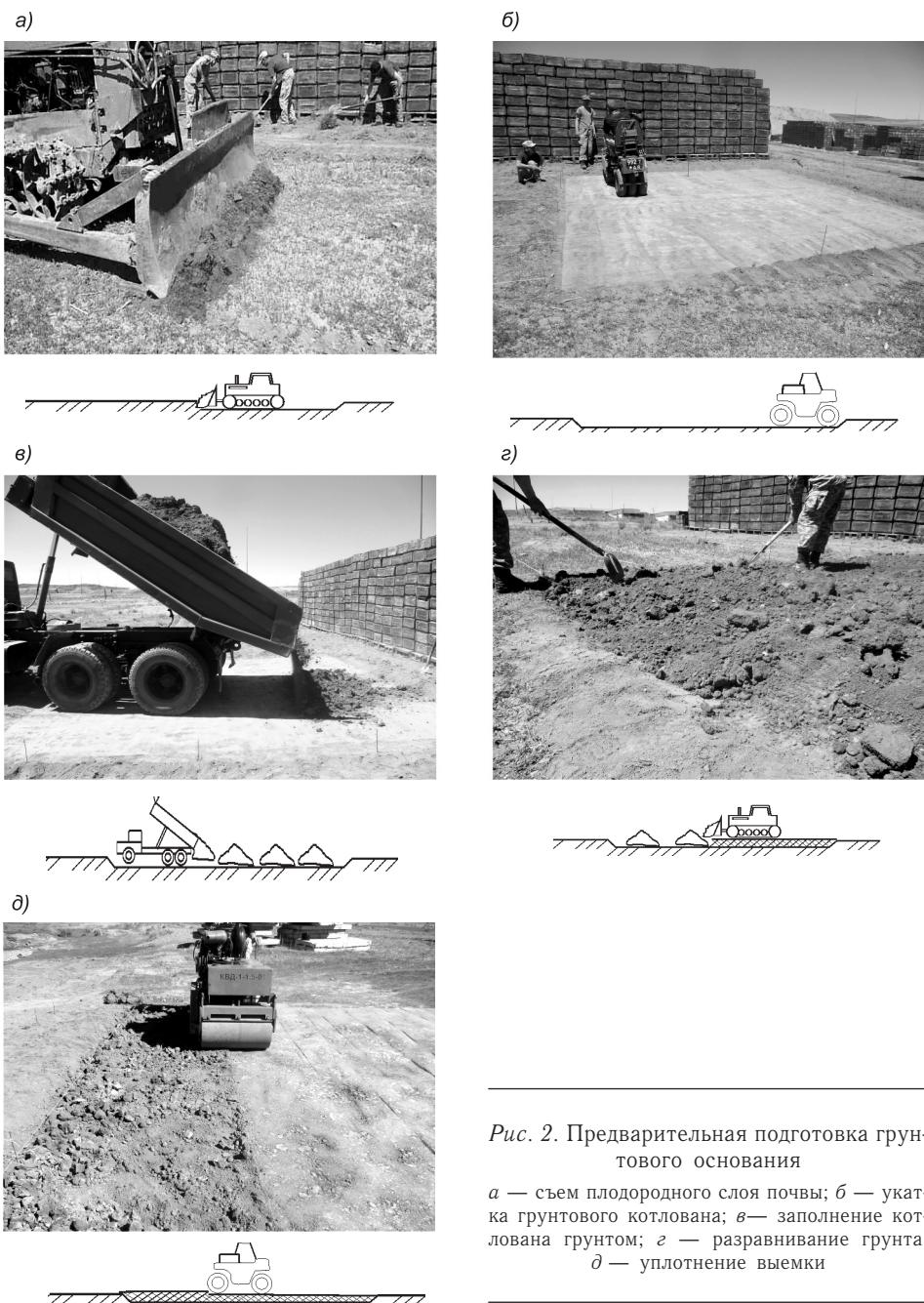
Рис. 2. Предварительная подготовка грунтового основания
