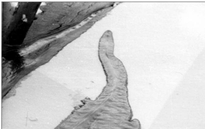
Рис. 2. Выпуск пульпы на ледяной покров отстойного пруда и образование слоев замкнутого льда в массиве хвостовых отложений
