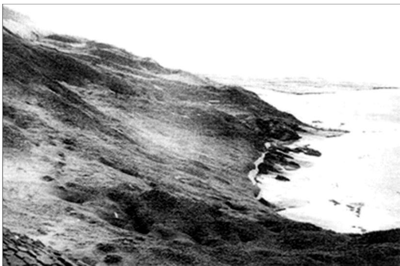
Рис. 3. Эрозионный размыв откоса при вытаивании погребенных снежников
