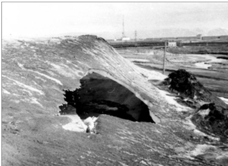
Рис. 7. Гидролакколиты у подошвы низового откоса дамбы
