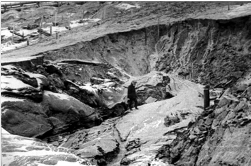
*Рис. 6. Фильтрационно-термокарстовое разрушение намывного массива низового откоса*
