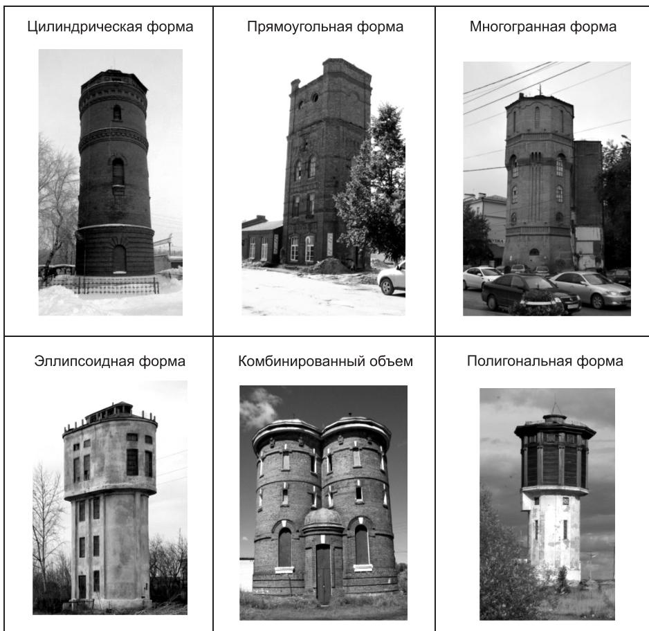
*Рис. 6. Объемно-композиционные и планировочные особенности водонапорных сооружений*
