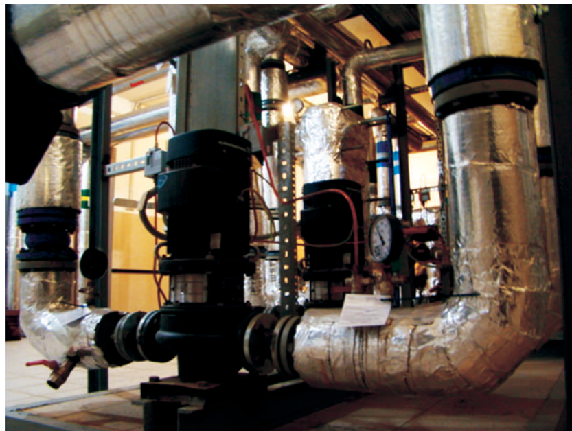
Рис. 1. Блок отопления с ненагруженным резервом насосной группы
