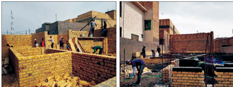
Рис. 2. Возведение таунхаусов из кирпича (бригада каменщиков на объекте)
