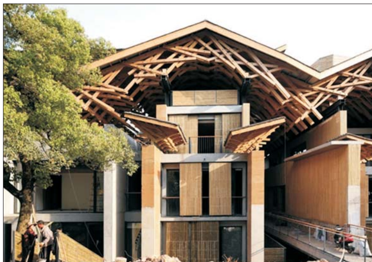
Рис. 3. Внешний вид Центра приема специалистов Академии художеств (а) и фрагмент фасада 2 (б)
