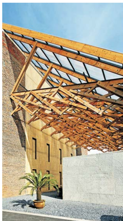
Рис. 4. Каркас крыши. Внешний вид 2
