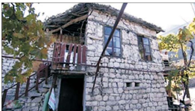
Рис. 1. Жилой дом в прибрежной зоне Сирии
