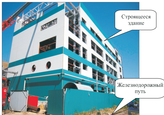
Рис. 1. Взаимное расположение строящегося здания и железнодорожного пути
