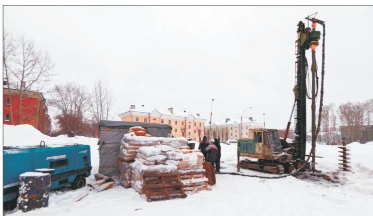
*Рис. 3. Изготовление вертикальных армирующих элементов по технологии глубинного перемешивания*
