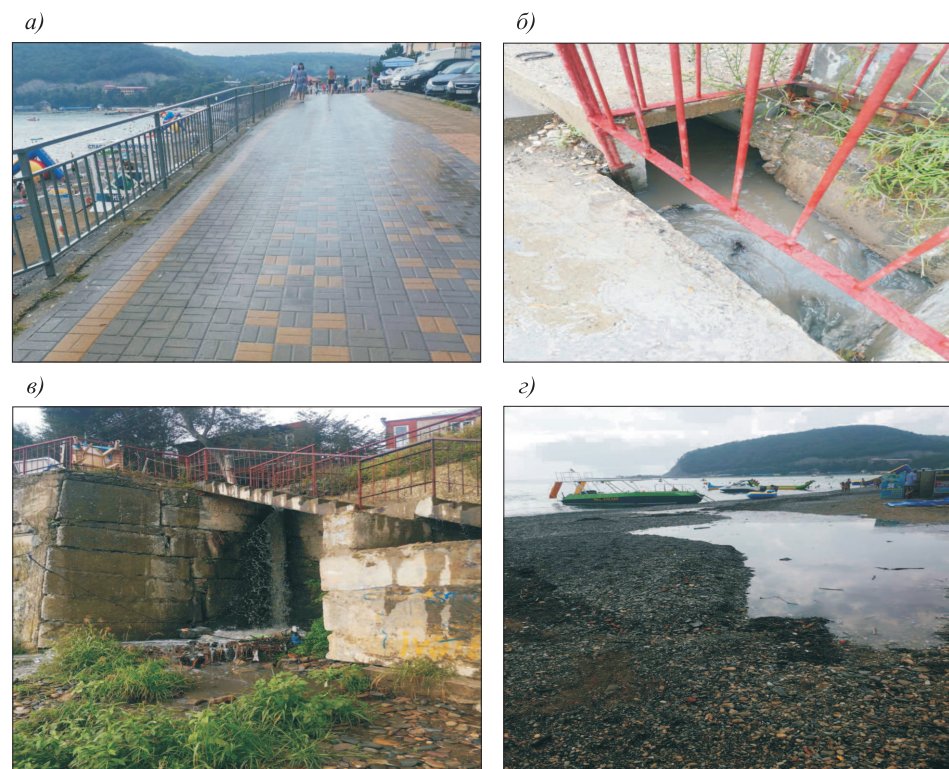
Рис. 2. Сброс ливневого стока в акваторию Черного моря а – покрытие водосборной площади; б – водосборный лоток, наполненный в период выпадения осадков; в – сброс ливневого стока на рельеф; г – сброс ливневого стока в акваторию Черного моря
