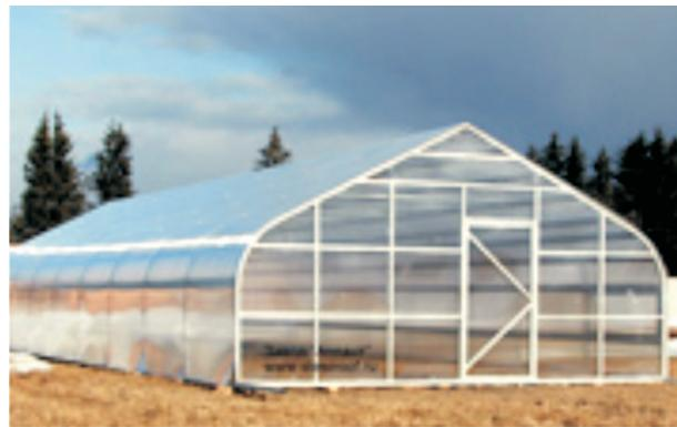
Рис. 1. Ангарная теплица с кровлей из поликарбонатных панелей
