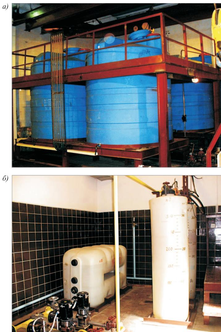
Рис. 2. Хлораторные обеззараживания вод гипохлоритом натрия
