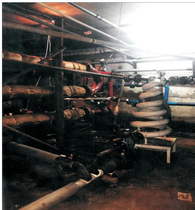
Рис. 3. Общий вид ИТП с секционным змеевиковым теплообменником
