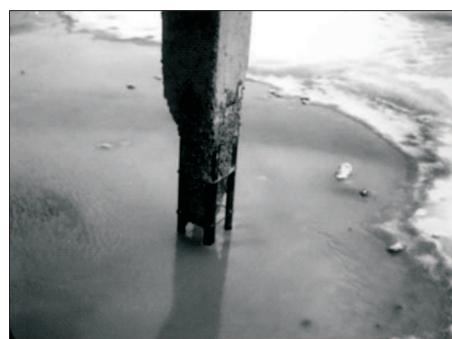
Рис. 5. Железобетонная опора автомобильного моста через 32 года эксплуатации
